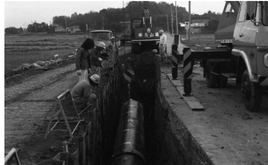
▲下水道管布設工事 昭和 50 年
