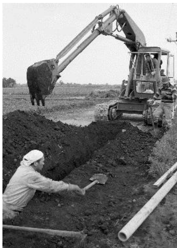
▲配水管布設工事 昭和41年
