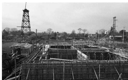
▲中央浄水場築造工事 昭和41年
