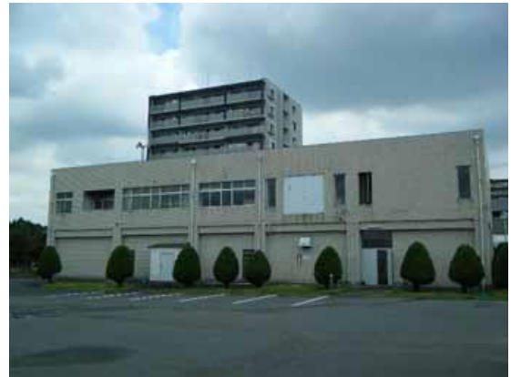
▲村上第2污水中継ポンプ場（村上南）
