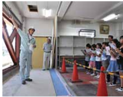
▲校内18か所を工事します
